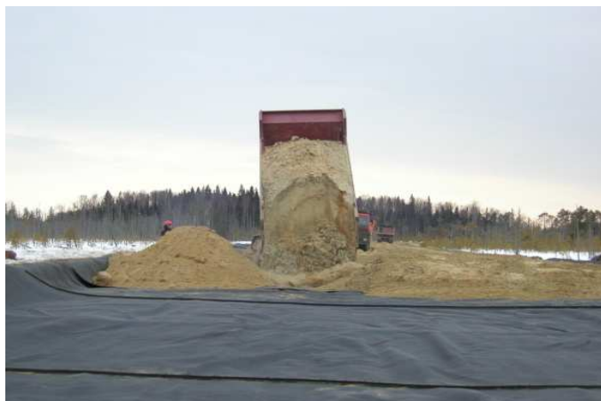
Рис.2. Отсыпка и уплотнение слоя насыпи.
