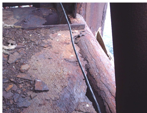
Рис. 4. Коррозионное растрескивание
