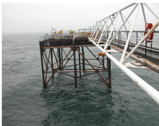
Рис. 4. Опорный блок, технологический модуль.
