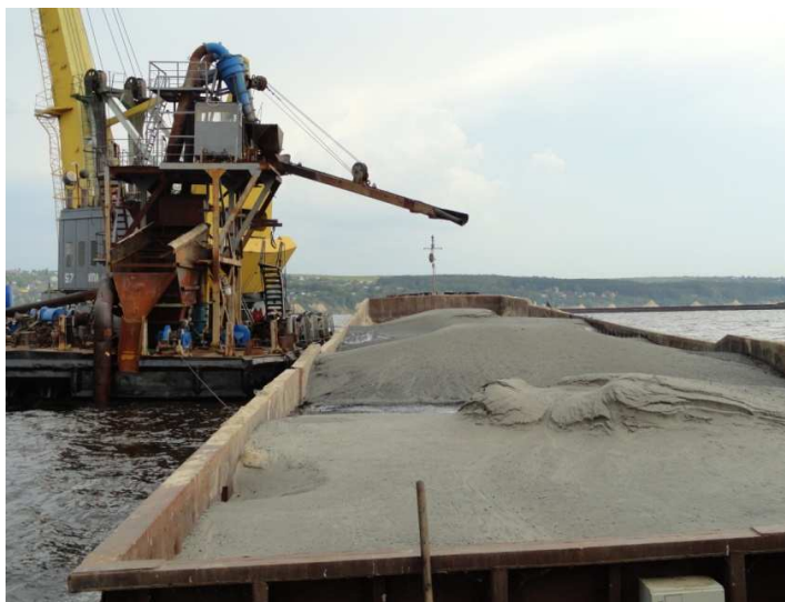
Рис. 4. Работа земснаряда землесосного типа (КПЛ 16-30 с погружным насосом типа DOP)
