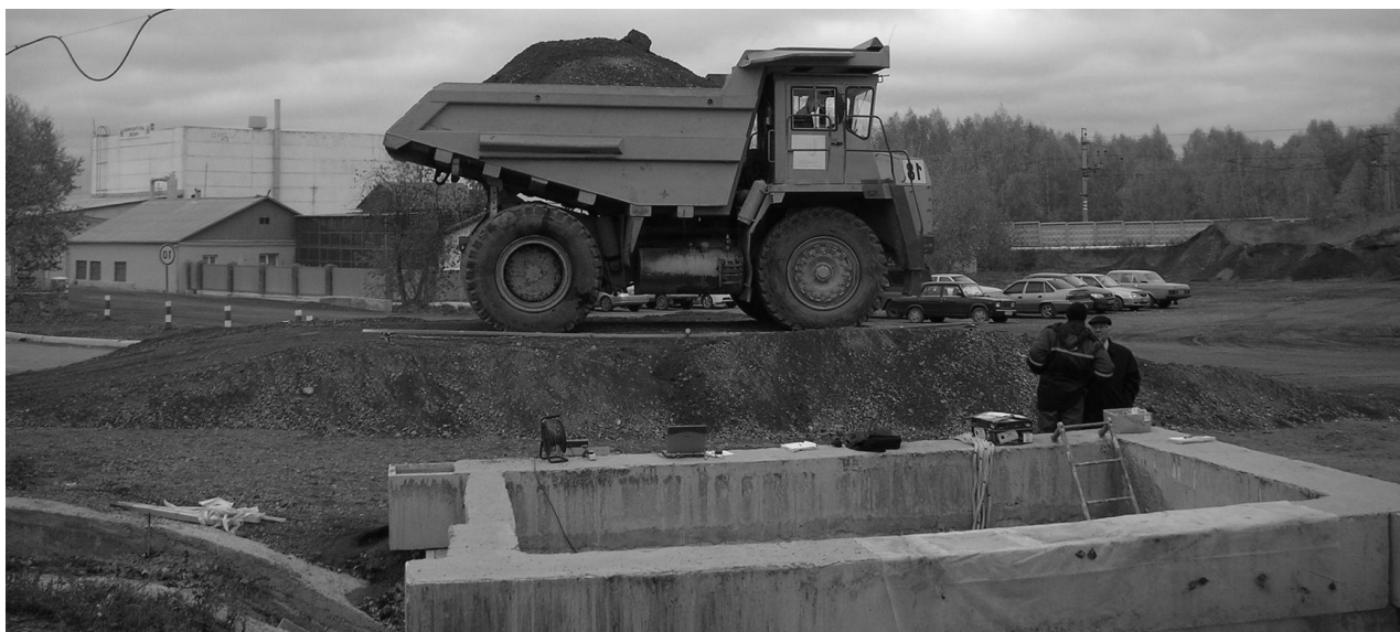
Рисунок 3. Испытание железобетонных труб карьерным самосвалом БелАЗ 7547 при высоте засыпки грунтом 2 метра.
