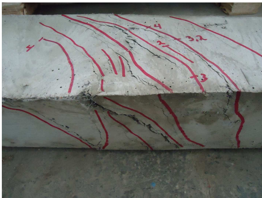
Рис. 5. Общий вид ФЖБ 1,5% после разрушения.
