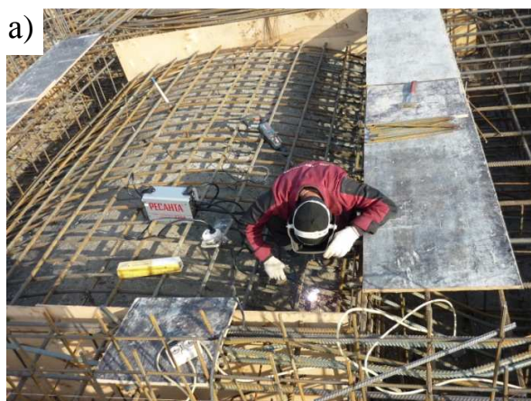
Рис. 6. Арматурные работы: а – криволинейные сетки оболочечной части; б – сопряжение плитной и оболочечной частей при помощи анкеров А1.
