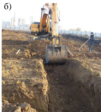
Рис. 3. Земляные работы: а - формирование криволинейных поверхностей вручную; б – отрывка траншей;
