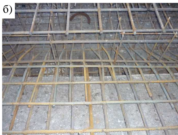
Рис. 6. Арматурные работы: а – криволинейные сетки оболочечной части; б – сопряжение плитной и оболочечной частей при помощи анкеров А1.
