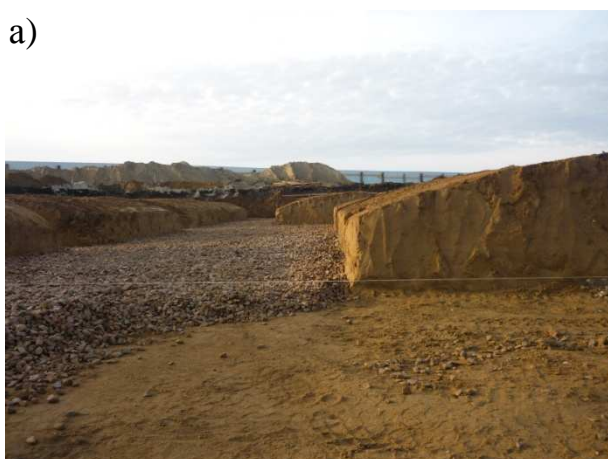
Рис. 4. Подготовительные работы: а – устройство щебеночной подготовки; б – устройство подготовки из тощего бетона;
