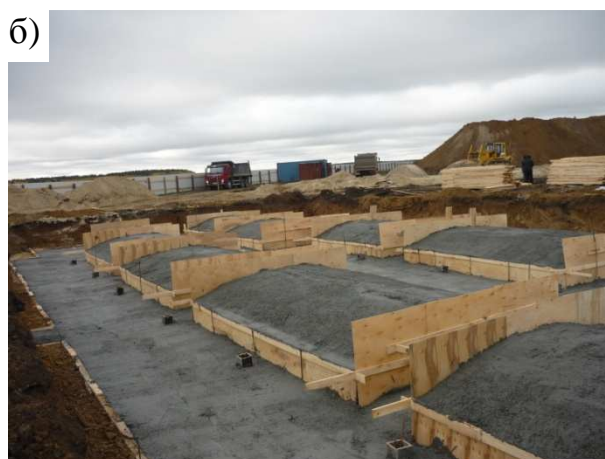
Рис. 4. Подготовительные работы: а – устройство щебеночной подготовки; б – устройство подготовки из тощего бетона;
