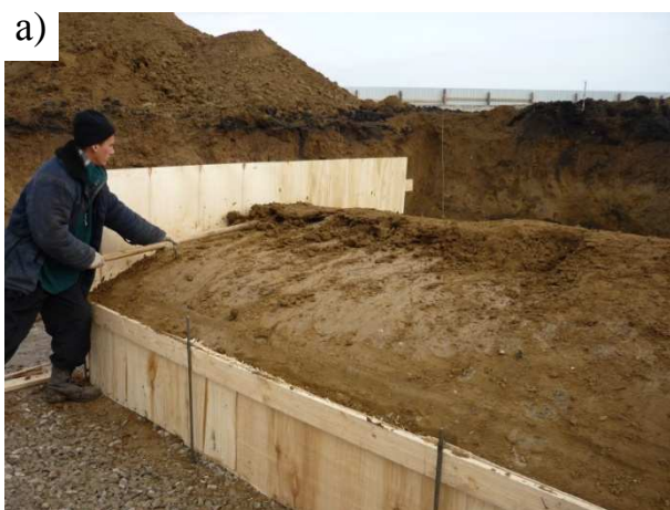
Рис. 3. Земляные работы: а - формирование криволинейных поверхностей вручную; б – отрывка траншей;
