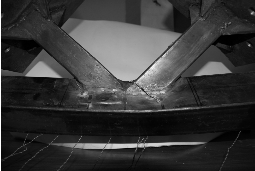
Рис. 5. Разрушение разработанного узла
