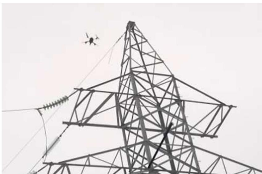
Рис. 1. Проведение аэровизуального инспектирования
