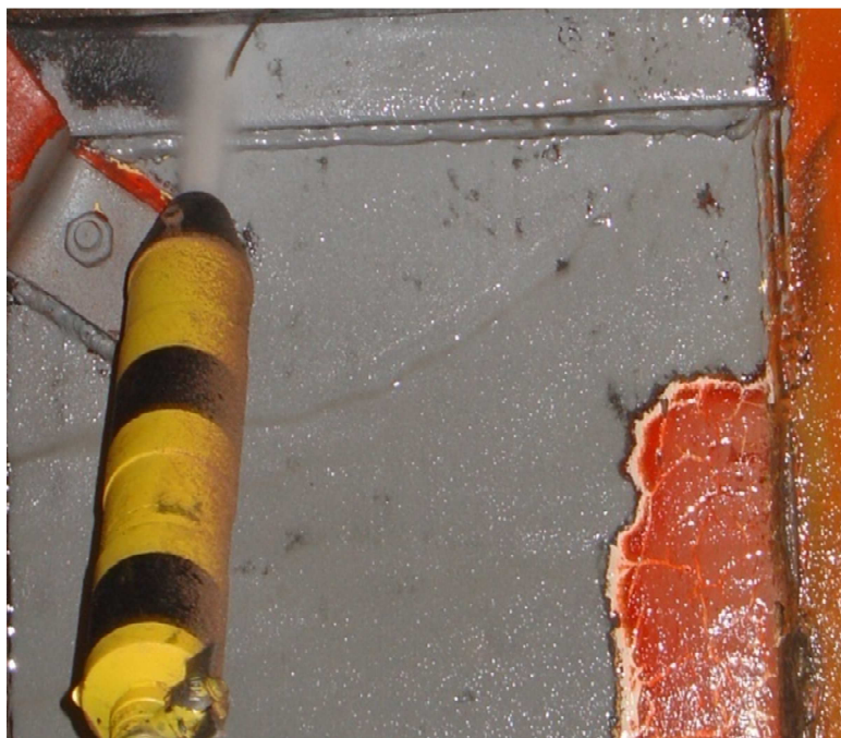
Рис. 1. Очистка поверхности металлоконструкций застарелого лакокрасочного покрытия.
