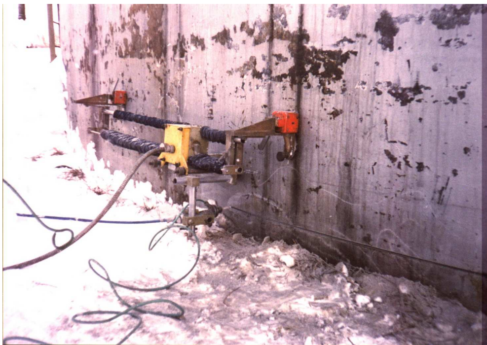
Рис. 1. Вырезание прямоугольного сечения на нефтехранилище
