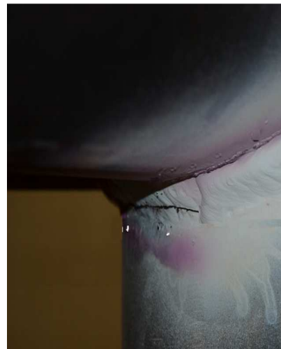
Рис. 3. Усталостная трещина в ЭУ таврового соединения.
