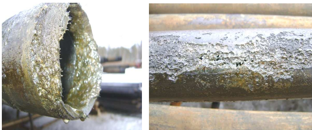
Рис. 1. Примеры коррозионного разрушения НКТ
