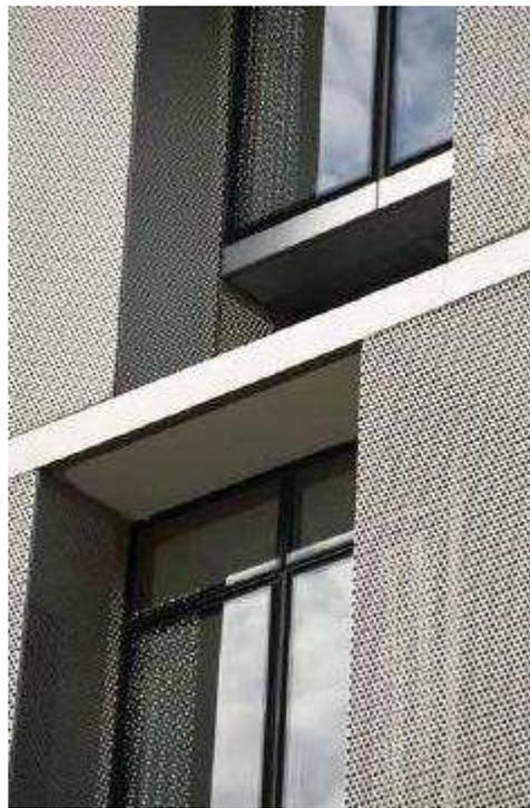
*Рис. 2. Защитный перфорированный экран*
