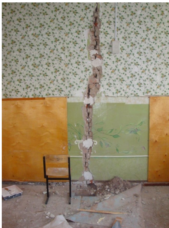
Фото 1. Трещина во внутренней стене в осях «1-2/Б» на третьем этаже
